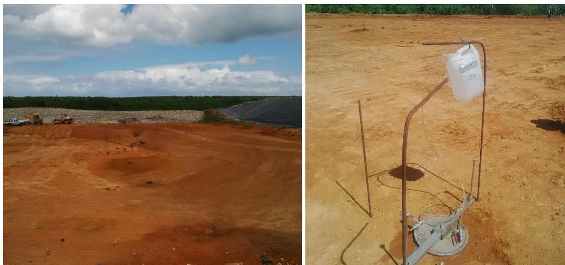
Figure 14 : Mise en place de la couche d'étanchéité passive du casier n°4 et test de perméabilité (mars 2015, crédits EODD)
