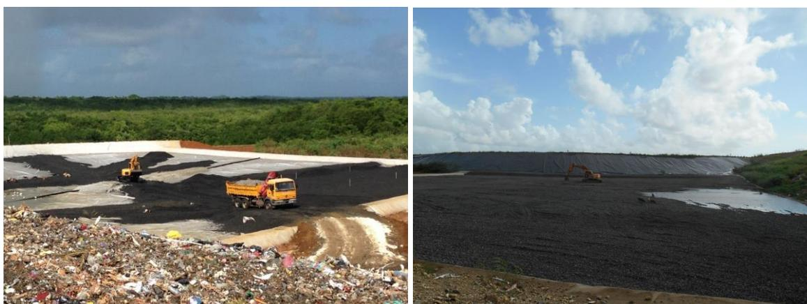
Figure 16 : Mise en place de la couche drainante au droit des casiers 3 (à gauche) et 4 (à droite), crédits EODD
