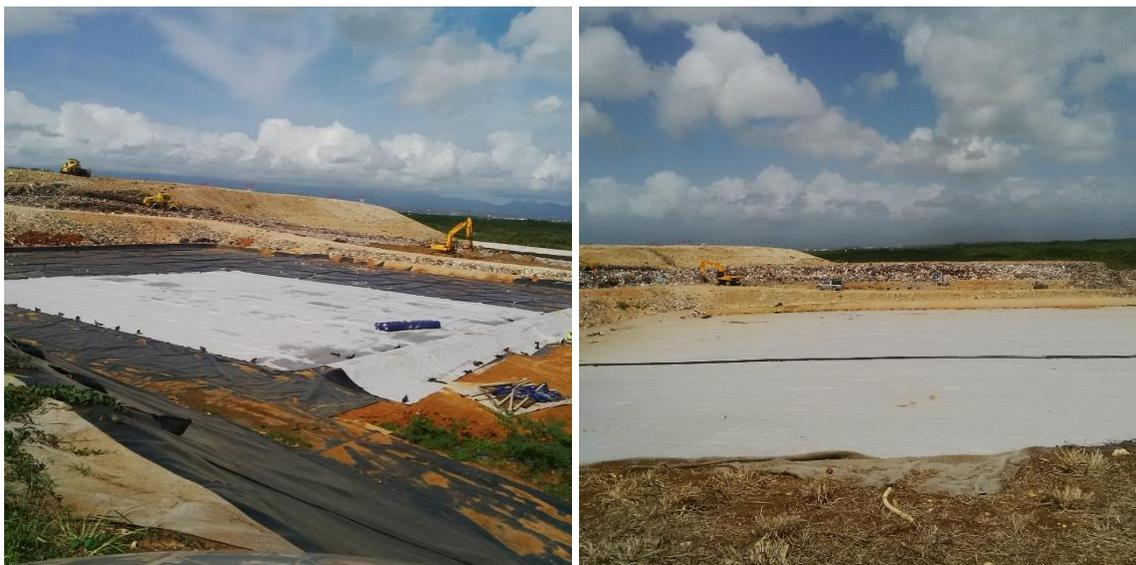
Figure 15 : Mise en place de la barrière active du casier n°4, crédits EODD
