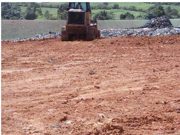
*Figure 23 - Aménagement d'une couverture provisoire*
