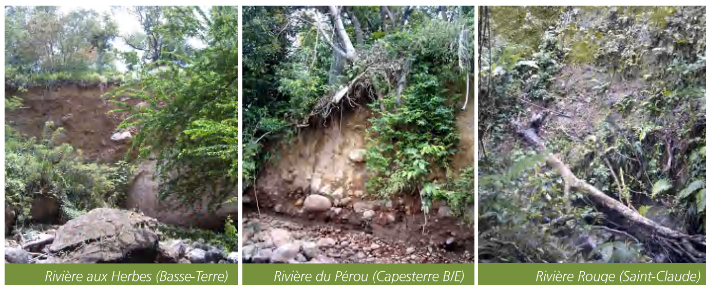
Figure 21 : Photographies de zones d'éboulement nécessitant une surveillance particulière
