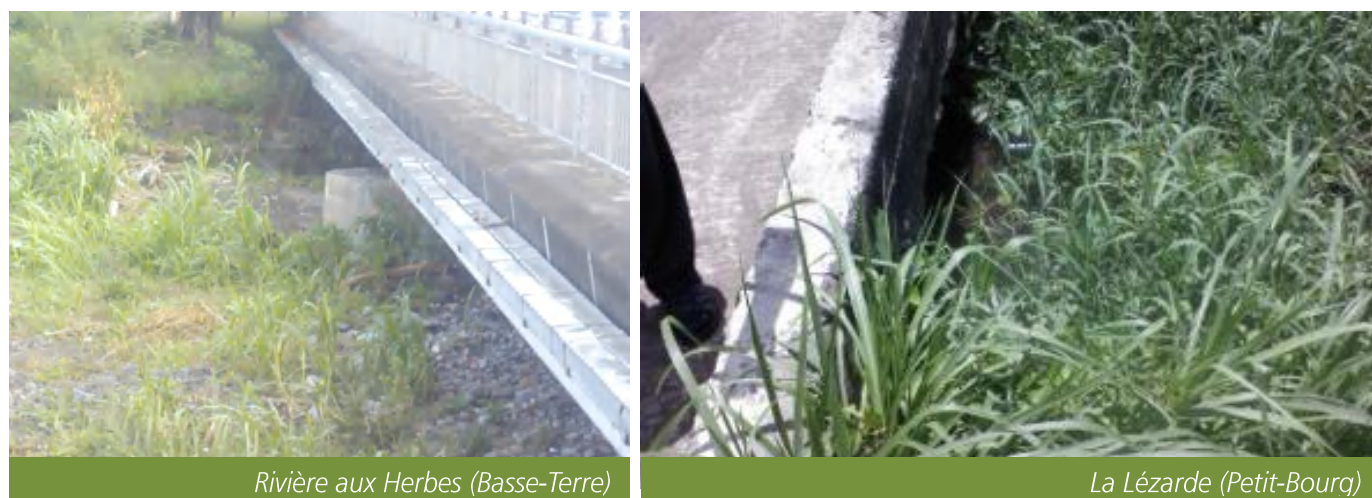
Figure 22 : Photographies de deux ouvrages nécessitant des travaux de curage
