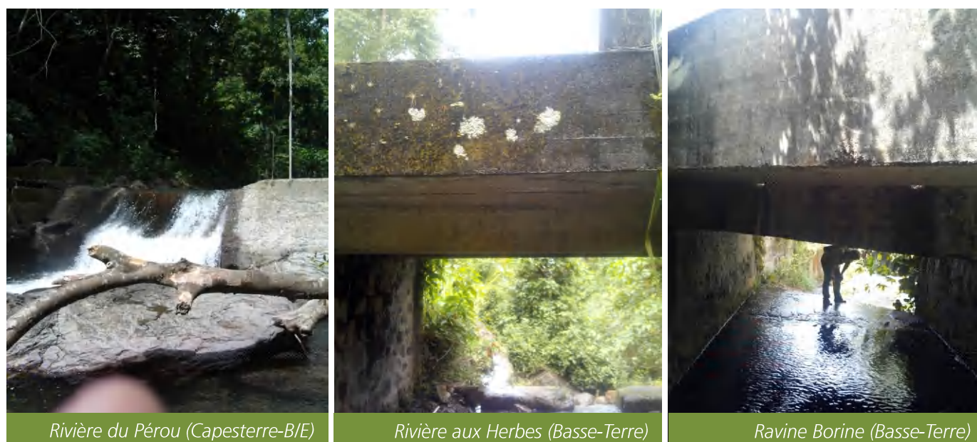
Figure 12 : Photographies d'ouvrages perturbant la continuité écologique des cours d'eau
