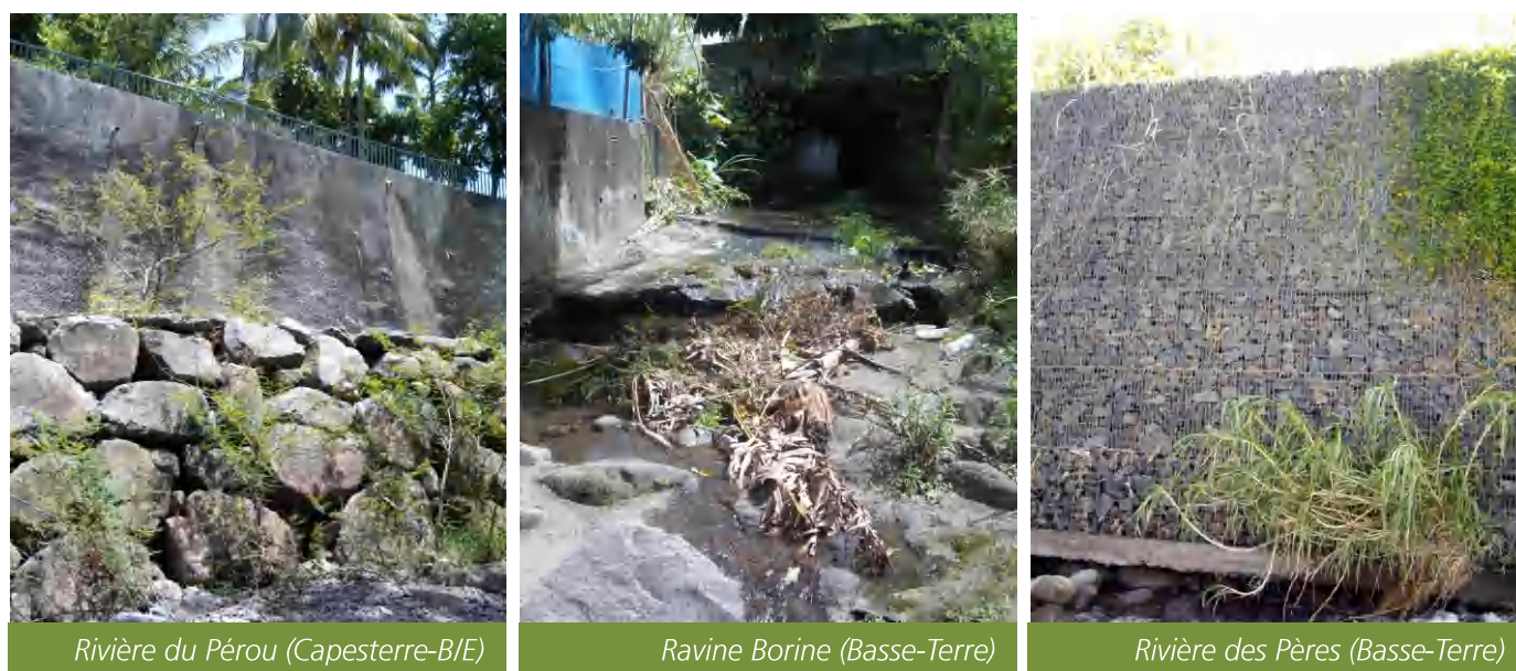
Figure 13 : Photographies de trois types de travaux de consolidation de berges observés en 2018 (gauche : travaux d'enrochements, centre : construction bétonnée, droite : gabions)
