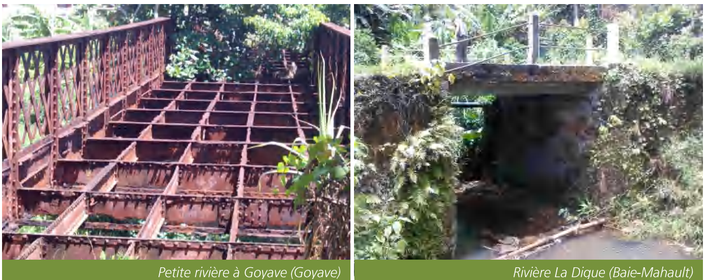
Figure 10 : Photographies des ponts en état « dégradé » observés en 2018
