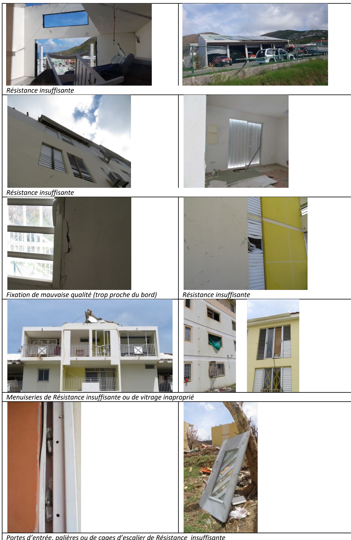
Figure 18 Illustrations par photos des dégâts de menuiseries
