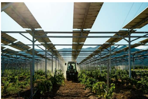
Photo 21: structure permettant le passage d'engins agricoles
