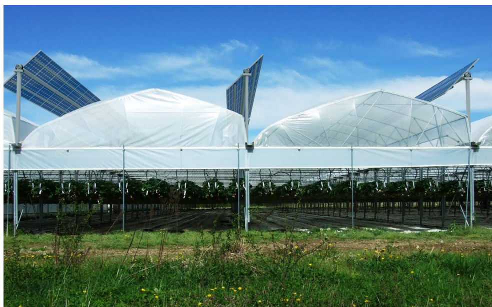
Figure 2 : Photomontage de notre système AVD sur serre multichapelle plastique
