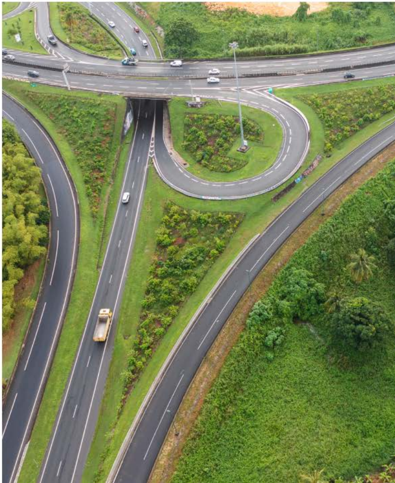
RN1-RN2 / Baie-Mahault, échangeur de Destreland : photographie datant de 2023 après la mise en oeuvre du projet TVR (c) Région Guadeloupe
