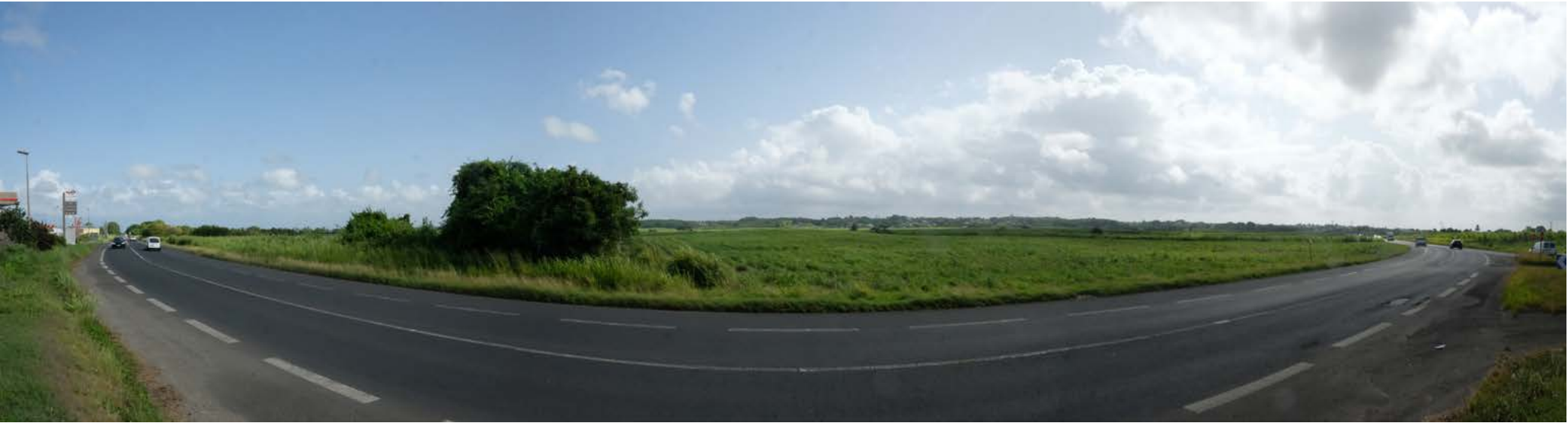
N5 - Plaine du Gripon / Section routière particulièrement large
