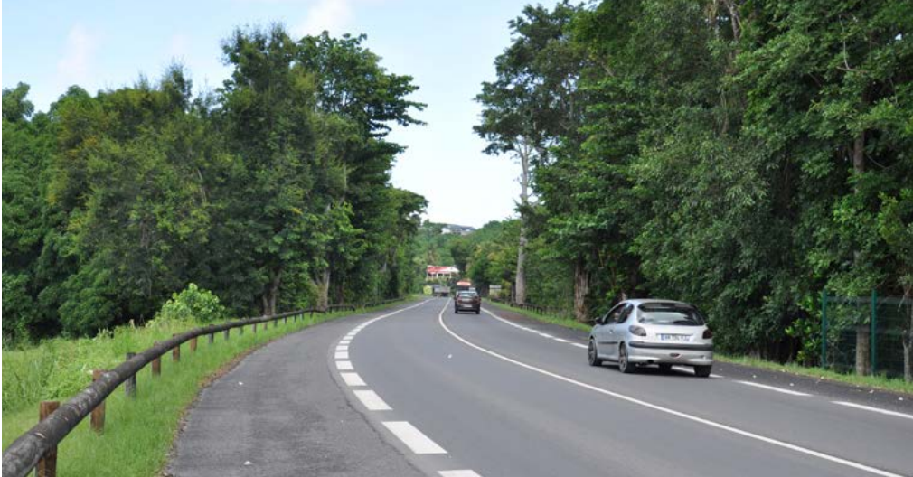
N5 / glissières de sécurité en bois, accotement asphalté dans la continuité de la chaussée et abords enherbés fauchés
