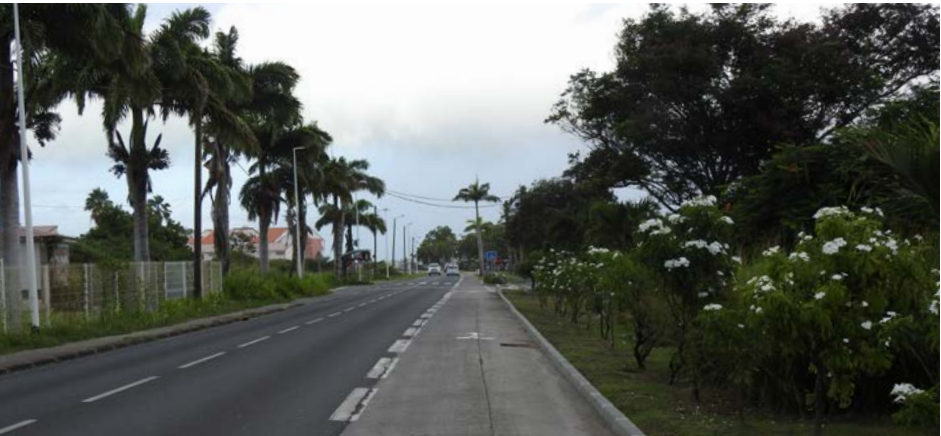
N4 - Saint-François / Piste cyclable sur accotement bétonné
