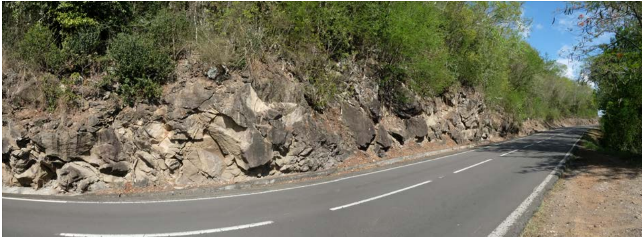
N2 - Côte-Au-Vent / Talus rocheux avec mise en valeur de la couche géologique
