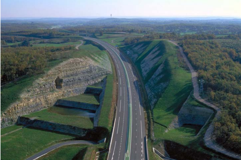
Aménagements paysagers liés à la création de l'A20, MOE Signes Paysages, Ruban d'Or 2002 / l'A20 traverse les reliefs complexes des Causses, occasionnant des déblais et des remblais parfois supérieurs à 50 m. Signes, lauréat du concours international, a proposé un traitement particulier des modelages et des sculptures des talus associés aux plantations qui forment des « agraphes ». (c) Signes
