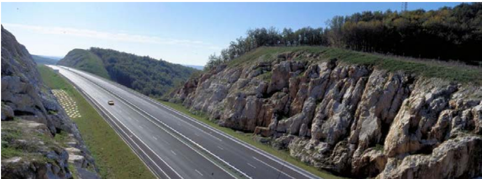
A75 aménagée en chaussée décalée afin de mieux s'insérer dans le relief
