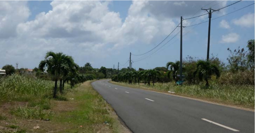
N8 - sortie d'Anse-Bertrand / Alignement de palmiers nains, hors échelle par rapport au paysage, ouverture visuelle généreuse sur le plateau calcaire
