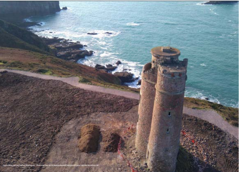
Remodeler le Cap Fréhel / état chantier où le stationnement est gratté pour recréer un vallon © Alain Freytet
