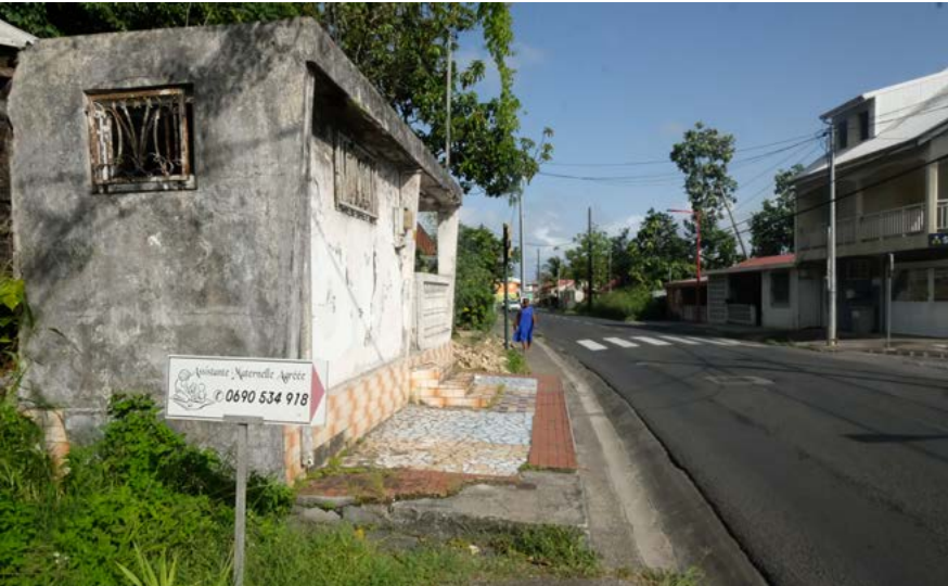
N5 - Morne à l'eau / Terrasse privée qui empiète sur l'espace public
