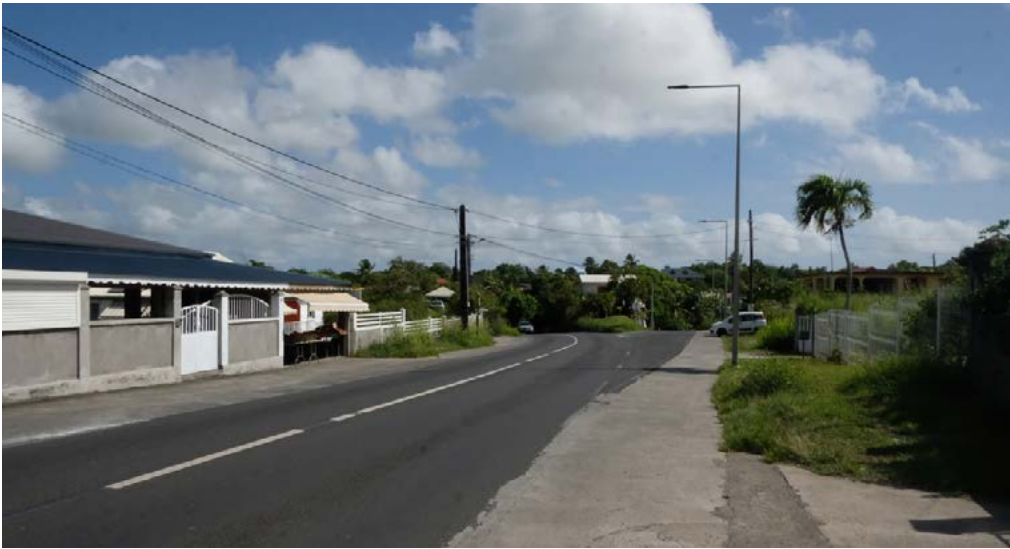
N6 - Rougeole / Accotements bétonnés
