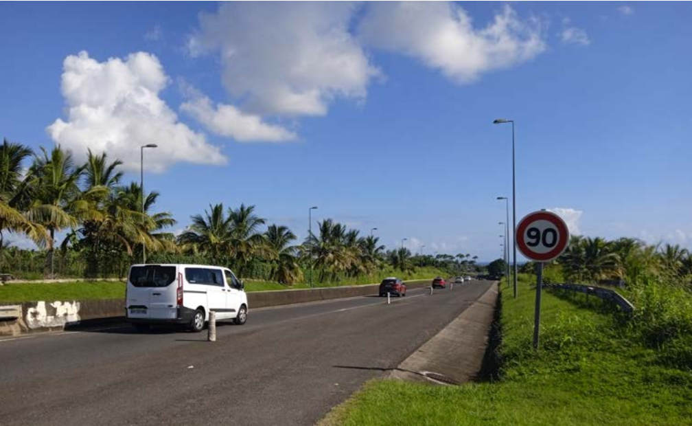
N1 / le nouveau paysage façonné par la voie de contournement de Capesterre-Belle-Eau
