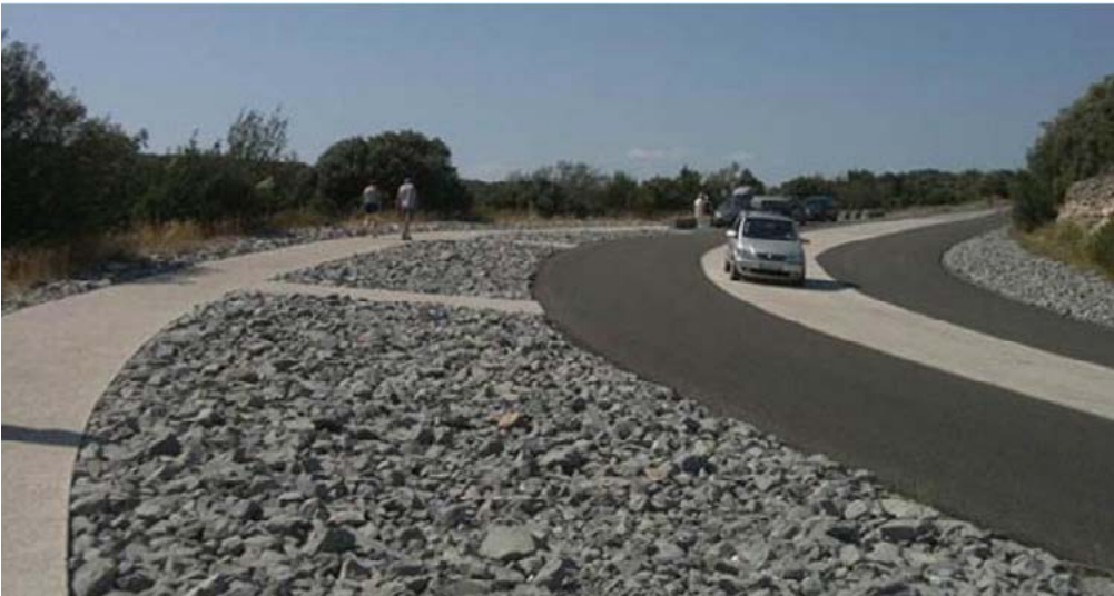
Espaces piétons en béton sablé de concassé calcaire bien délimités (c) P. Pierron Paysagiste
