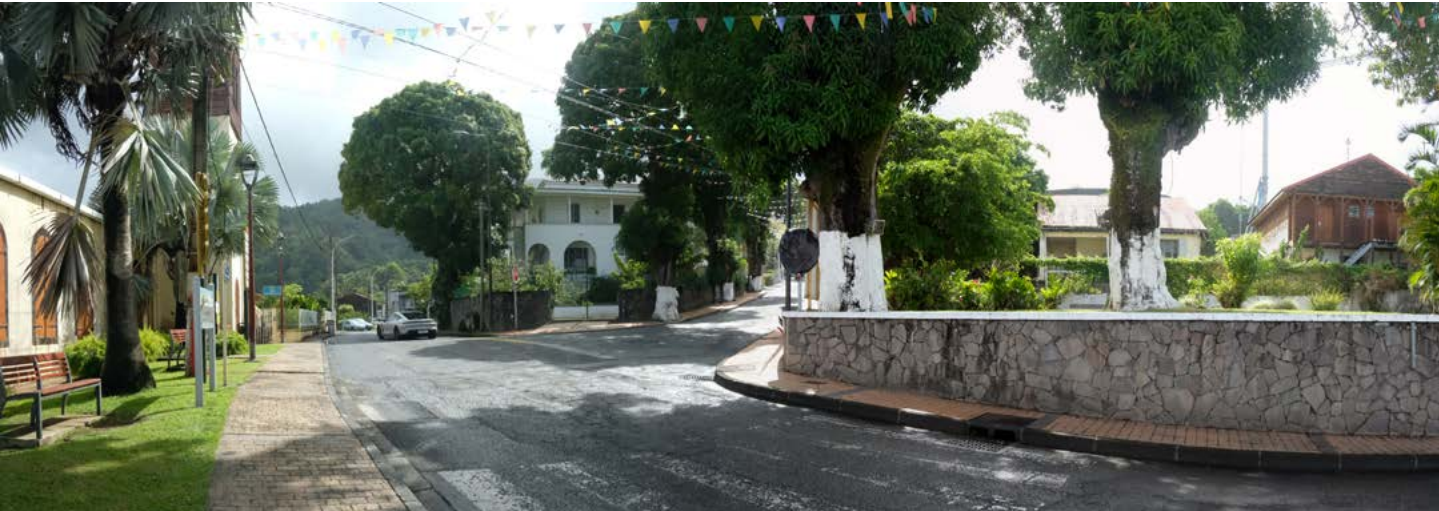
N3 - Saint-Claude / Traversée urbaine caractérisée par des trottoirs, du mobilier urbain et des arbres isolés
