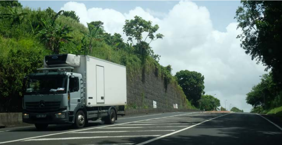
N1 / soutènement en gabions remplis de granulats
