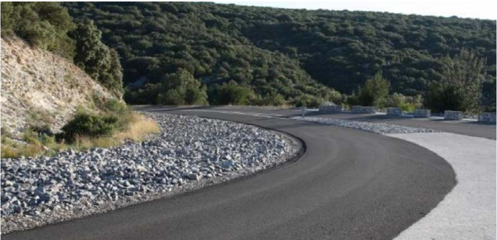
Tapis dissuasifs de concassé pour éviter le stationnement diffus (c) P. Pierron Paysagiste
