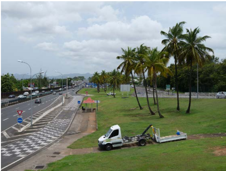
RN1 / Baie-Mahault, la Jaille : photographie datant de juillet 2021 avant la mise en oeuvre du projet TVR (c) Sylvain Duffart, OPP
