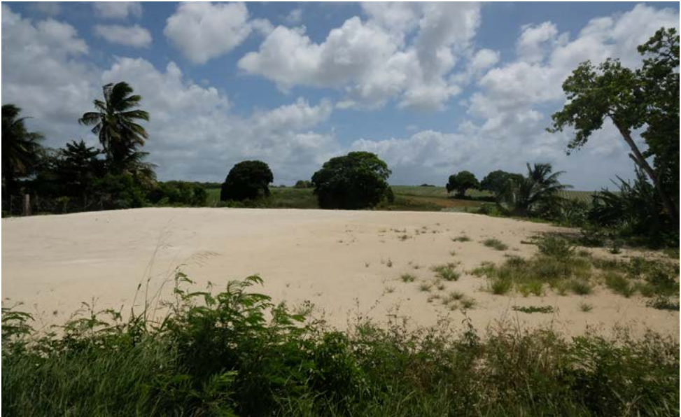
N8 - Pelletan Sud / Terrassement préliminaire à l'urbanisation au 1er plan d'un paysage ouvert entraînant la privation de paysage depuis l'axe routier
