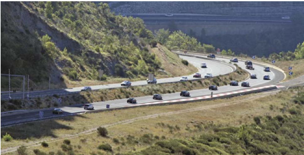
A75 aménagée en chaussée décalée afin de mieux s'insérer dans le relief
