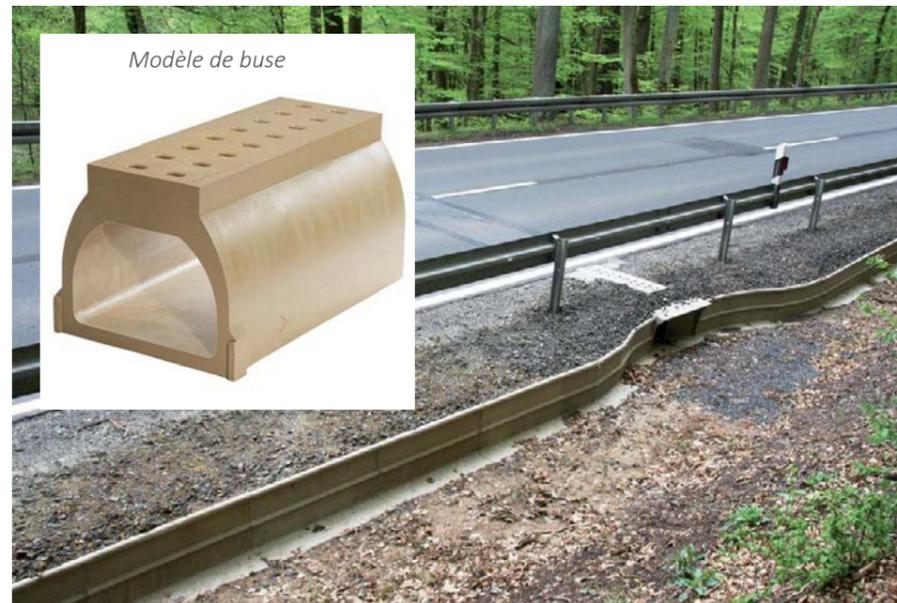
Exemple d'un passage sous chaussée
