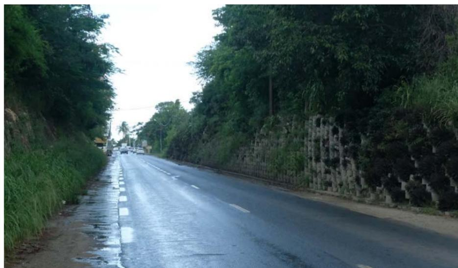
*N5 / Entrée nord dans Saint-François : la route traverse l'extrémité de la Barre de Bragelone (soutènement en casier béton à droite)*
