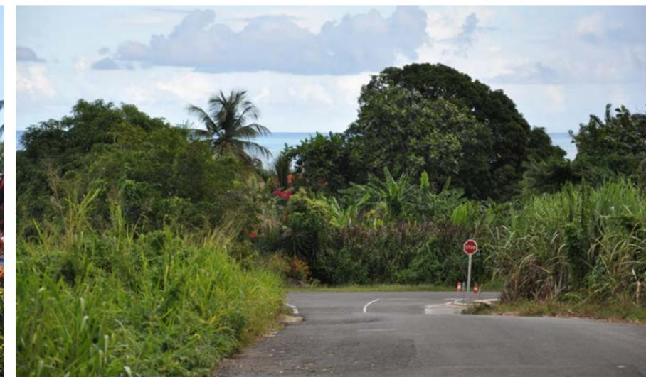
*Mauvais entretien des zones de dégagement de visibilité : fauchage nécessaire des bandes de sécurité (1,50 mètre de large depuis le bord de chaussée) et d'un triangle de sécurité adapté à la configuration pour un « stop »*
