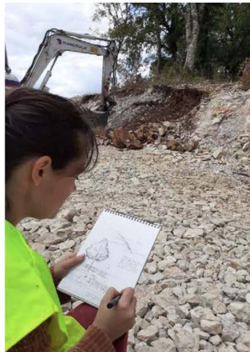
*Alice Freytet, paysagiste DPLG dessine sur le chantier le modelé du talus avant que n'intervienne la pelle mécanique pour conserver quelques éperons calcaires que viendra compléter un muret en pierre sèche, AF*
