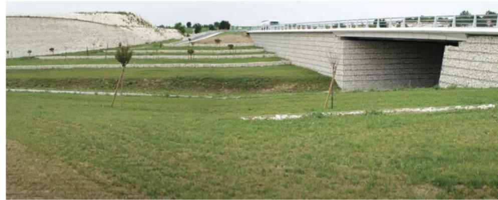
*Échangeur de Saintes : ouvrages et terrasses en Terratrel (mur constitué de panneaux de treillis d'acier à mailles soudées disposés verticalement et montés par rangs horizontaux) (c) Folléa + Gautier*
