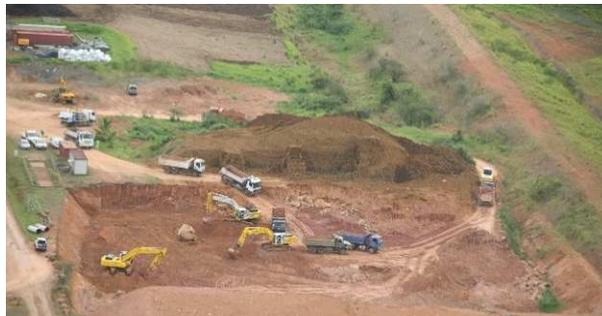
Figure 19 - Travaux d'aménagement d'une alvéole
