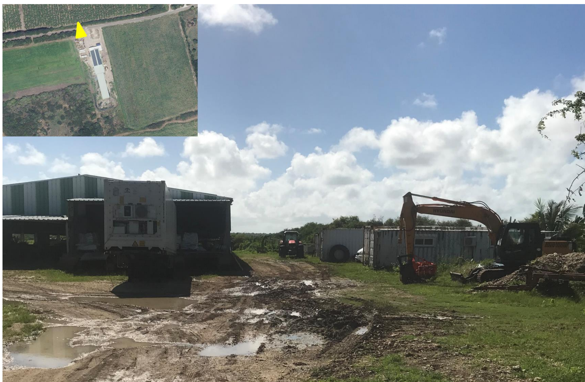
Figure 3 : Vue rapprochée n° 1 sur la partie Ouest du secteur d'étude
