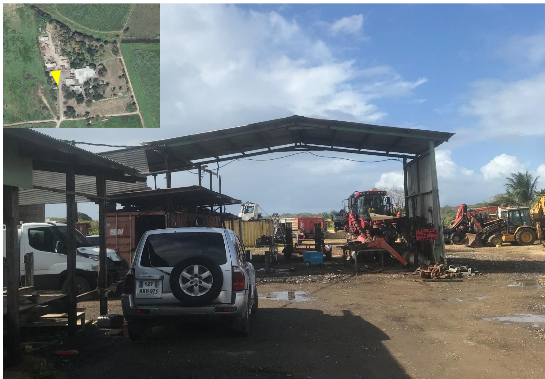
Figure 3 : Vue rapprochée n° 1 sur la partie technique du secteur d'étude
