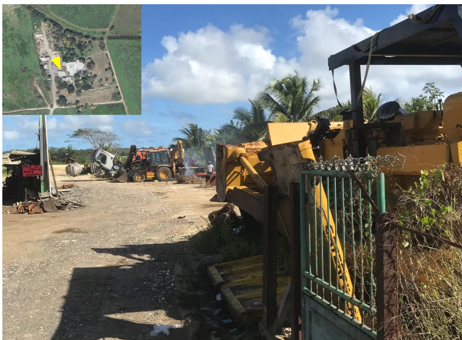
Figure 4 : Vue rapprochée n° 2 sur la partie technique du secteur d'étude
