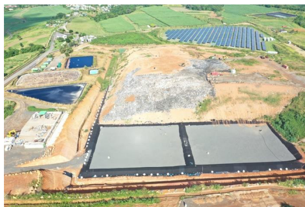
Figure 35 – Alvéoles H2 et H3 niveau drainant
