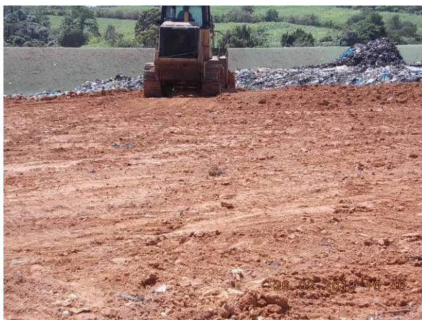
Figure 36 - Aménagement d'une couverture provisoire
