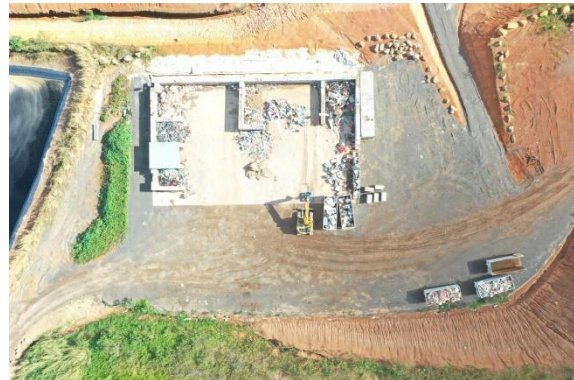
Figure 39 : Plateforme de tri 1 000 m 2
