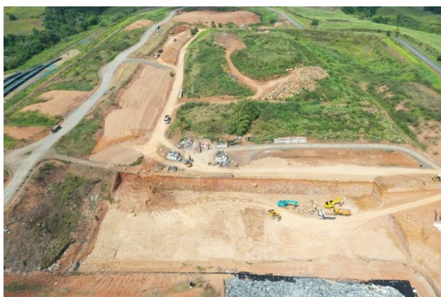
Figure 34 - Travaux alvéoles H2 et H2
