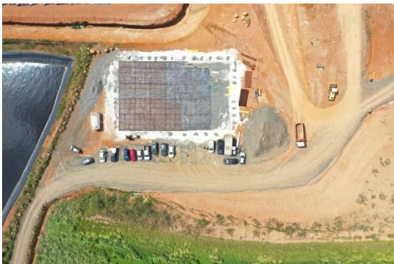
Figure 38 : aménagement plateforme de tri
