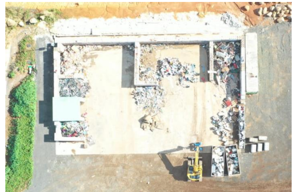
Figure 2 : Vue aérienne de la plateforme de tri
