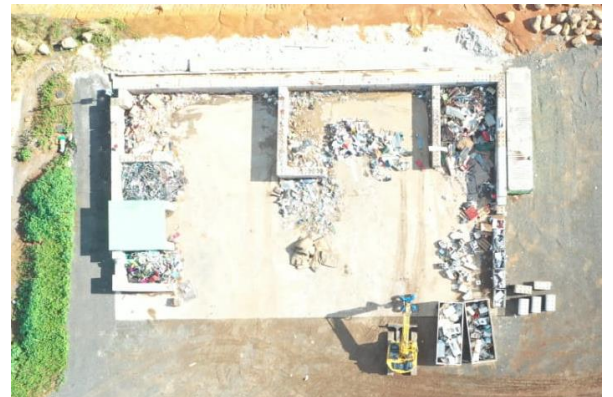
Figure 2 : Vue aérienne de la plateforme de tri
