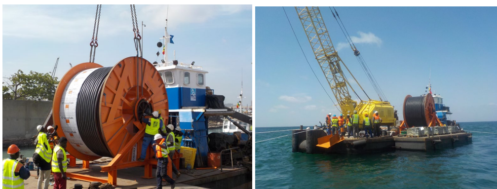
Figure 18 : Navire câblé au cours d'une opération d'atterrage
