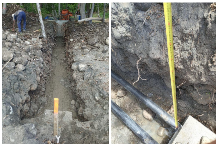
Figure 3 : Vue de la tranchée reliant le bloc d'atterrage à la chambre de plage (Terre-de-Haut, Les Saintes)
