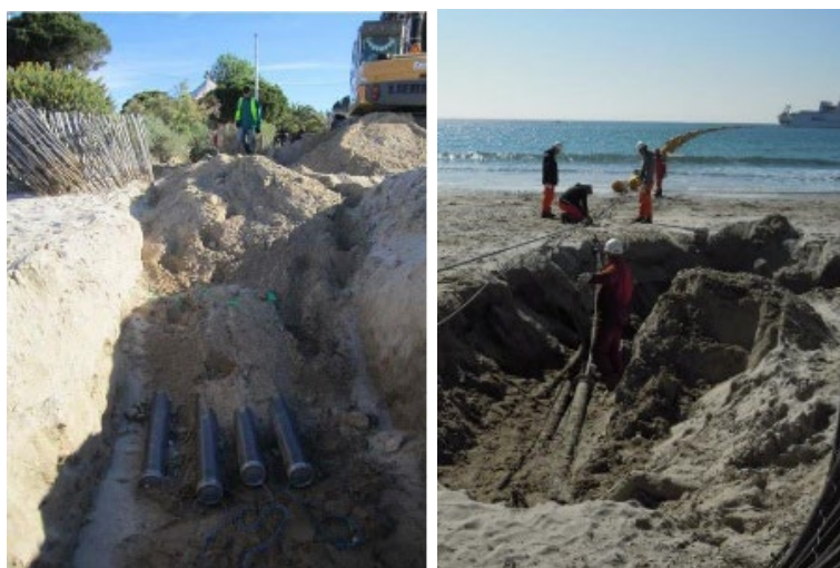
Figure 17 : Exemple d'illustration de l'installation de conduites d'accueil en haut de plage (à gauche), puis de conduites dégagées à l'occasion de travaux préparatoires à la réception d'un câble (à droite)
