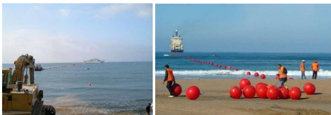
Figure 21 : Tirage du câble en flottaison par navire annexe et câble (à gauche) et câble en flottaison à l'aide
