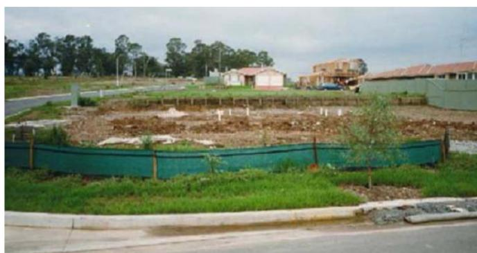
Figure 19 : Exemples de dispositifs de rétention des sédiments
