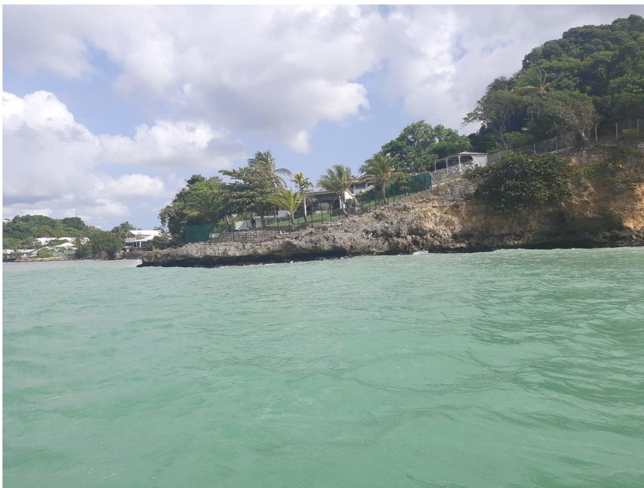
Photo 14 : Vue depuis la mer de la zone à l'Ouest de la zone de projet
