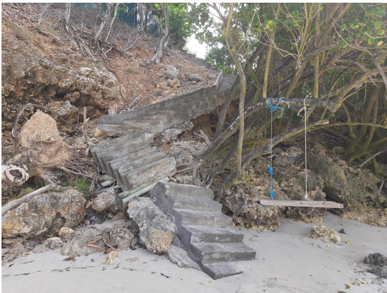
Photo 2 : Escalier d'accès à la plage, depuis la propriété du GPMG
