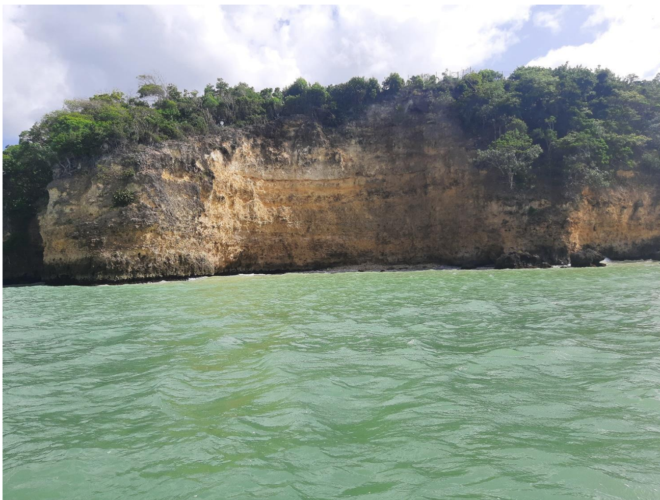
Photo 21 : Vue sur les falaises à l'Est, au droit du musée départemental
