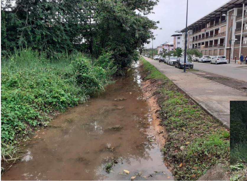
Canal hibiscus après curage – Avant travaux
