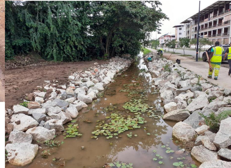
Travaux de plantations canal Hibiscus
