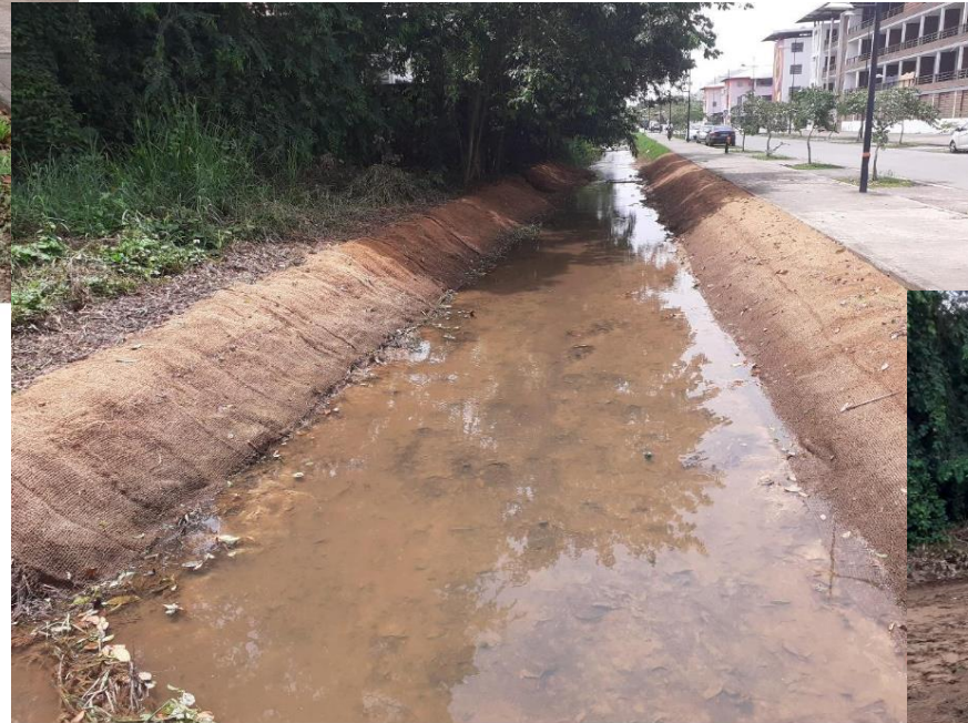
Mise en œuvre de la géonatte
