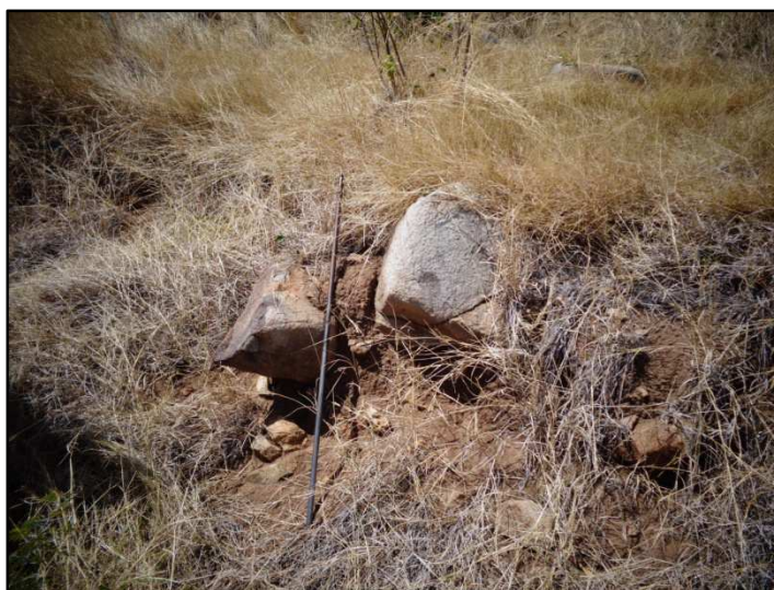
Photo n°8 : vue du talus amont bordant le chemin situé sur la parcelle. On observe la présence de blocs pluridécimétriques pris dans le niveau d'altération du substratum.
