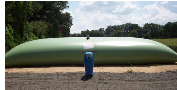
Figure 15 : Exemple d'une citerne souple d'une installation photovoltaïque
