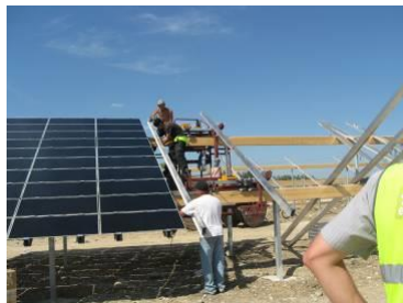
Photographie 5 : montage de modules sur des supports fixes
