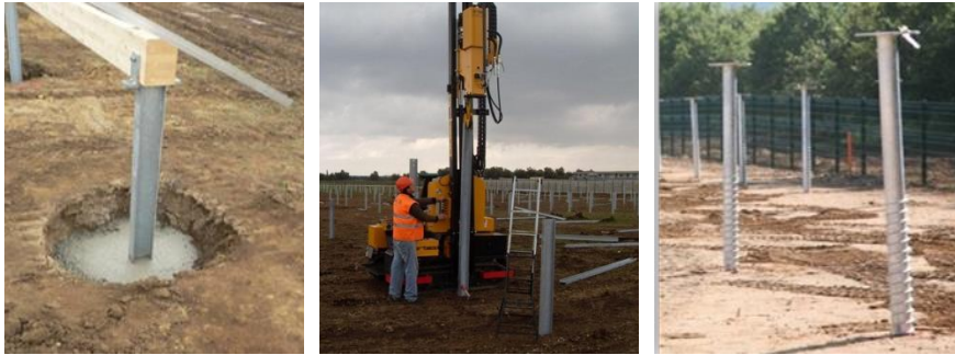
Photographie 4 : Fondation béton (à gauche), pieux battus (centre) et fondation vis (à droite)
