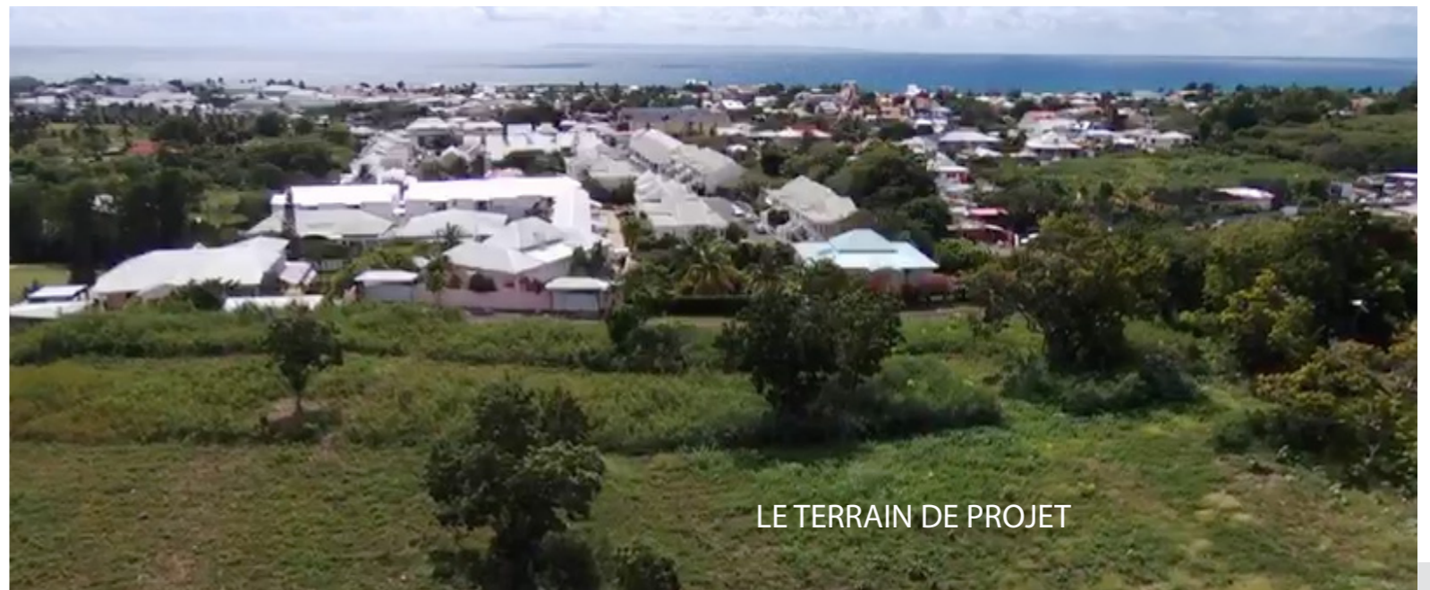
2-Vue aérienne du terrain, et de son environnement lointain : le centre-bourg et le littoral au loin
