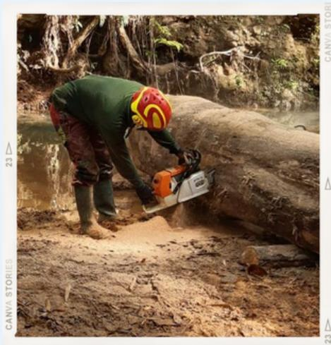
Tronçonnage d'un embâcle au travers du lit mineur du cours d'eau, ONF
