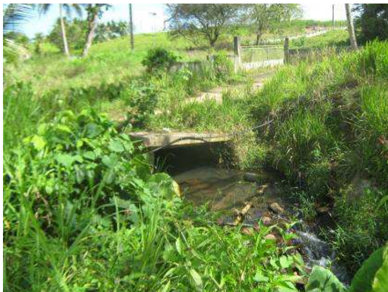
Figure 19 : Photographie de l'ouvrage n°2
