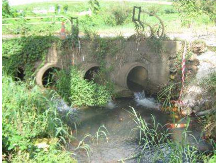
Figure 18 : Photographie de l'ouvrage n°1
