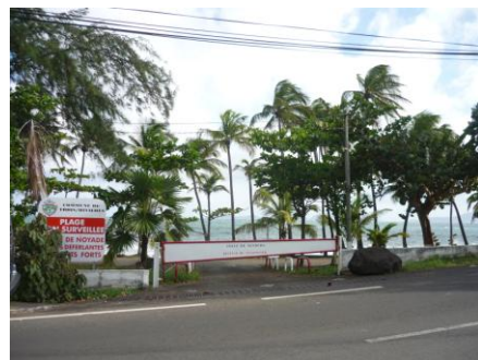
Entrée réservée aux secours et aux services techniques
