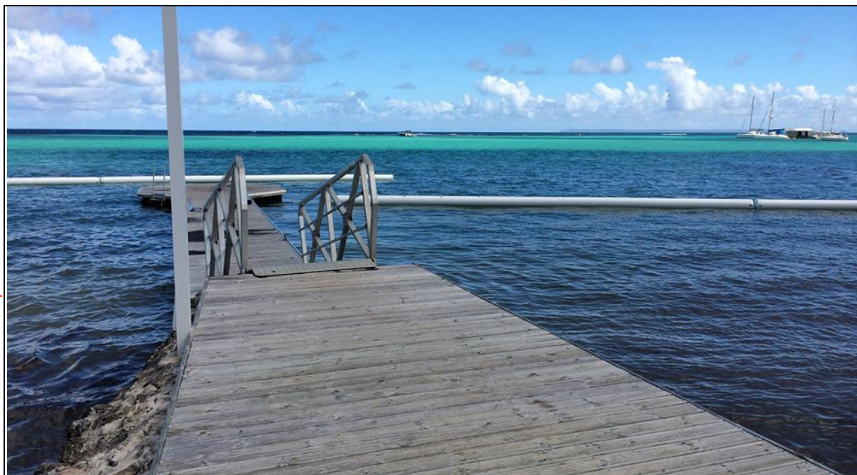
Photo n° 8: Barrage flottant mis en place au droit des villas n°9 et n°10 de la résidence des « Jardins du Hamak » (VillaBoubou, 08/09/2015)
