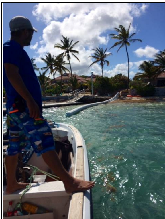
Photo n° 5 : Opération de pose d'installation du barrage flottant (VillaBoubou, 08/09/2015)
