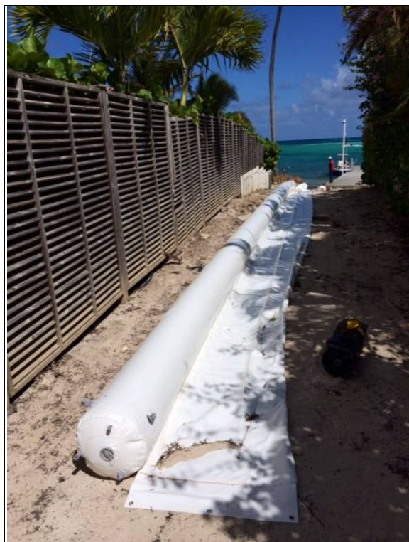
Photo n° 4 : Préparation du barrage flottant à terre (VillaBoubou, 08/09/2015)
