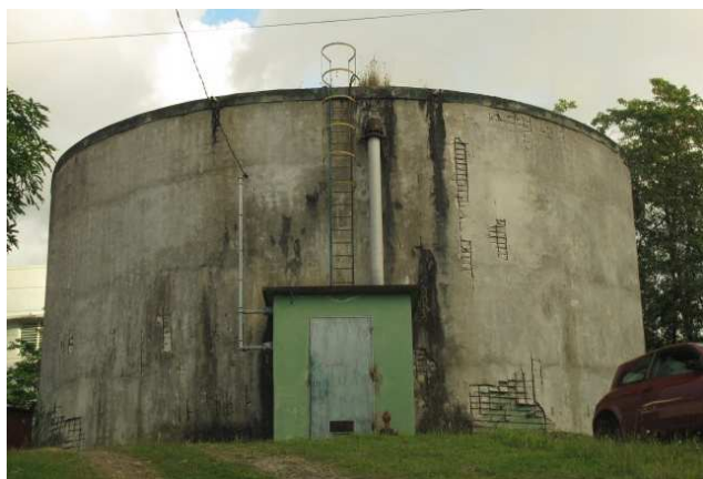
Illustration 8 : Ancien réservoir de stockage de Desmarais (DR)
