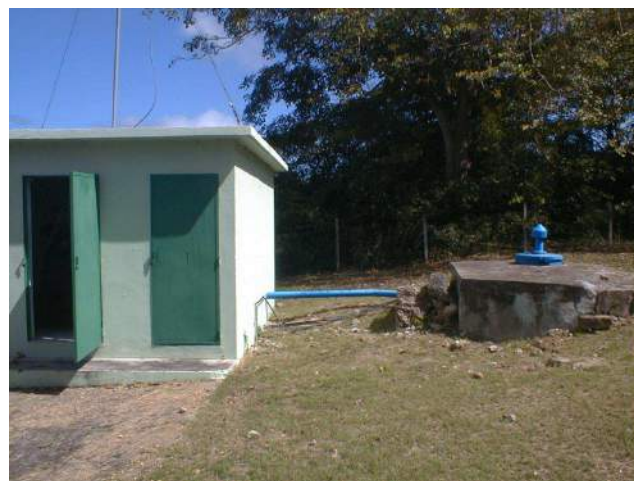
Illustration 9 : Local d'exploitation et capot du forage de Celcourt (DR)
