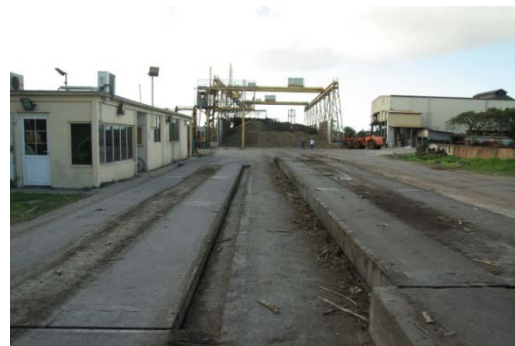
FIGURE 33: CENTRE DE TRANSFERT DU MOULE (USINE DE GARDEL), SOURCE CATRAM
