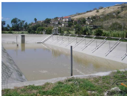
FIGURE 23: BASSIN DE DECANTATION DE VINASSE
