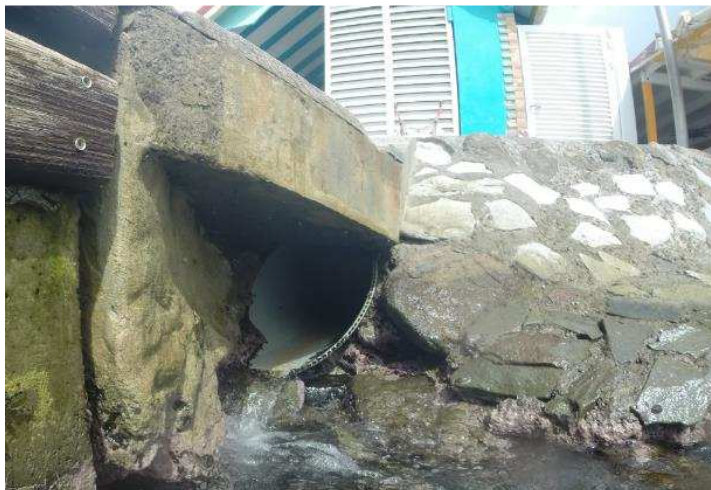
Figure 5 : Parement en béton et réseaux d'assainissement présent à proximité du ponton des pêcheurs
