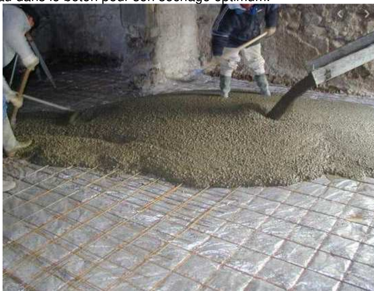
Figure 14 : exemple de polyane sous une dalle béton
