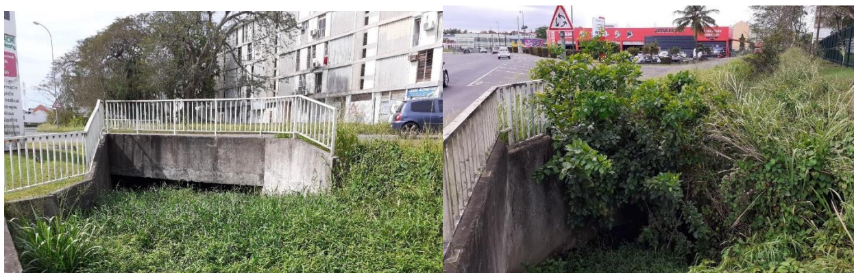
FIGURE 3 OH 17 (RD 129) – CADRE/ DOUBLE DALOT AMONT (GAUCHE) ET VUE VERS L'AVAL DEPUIS L'AVAL (DROITE)
