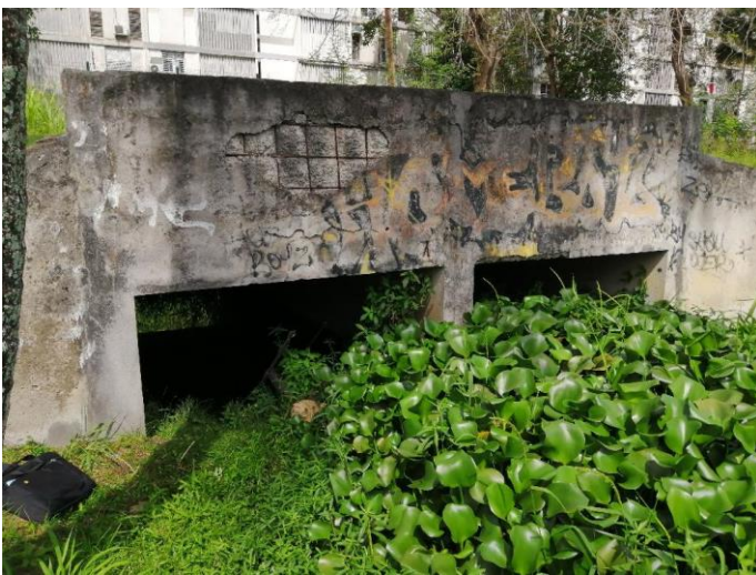
FIGURE 5 OH 16 ROUTE D'ACCES A L'ATELIER DE REPARATION AUTOMOBILE (VUE DEPUIS L'AVALE)
