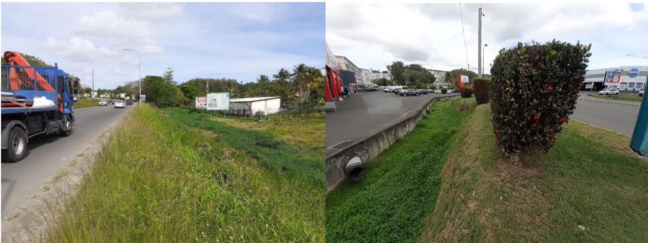
FIGURE 12 LIT MINEUR AMONT ET AVAL DE LA RD129 ENHERBE (GAUCHE) ET FOSSE ENHERBE EN AVAL(DROITE)
