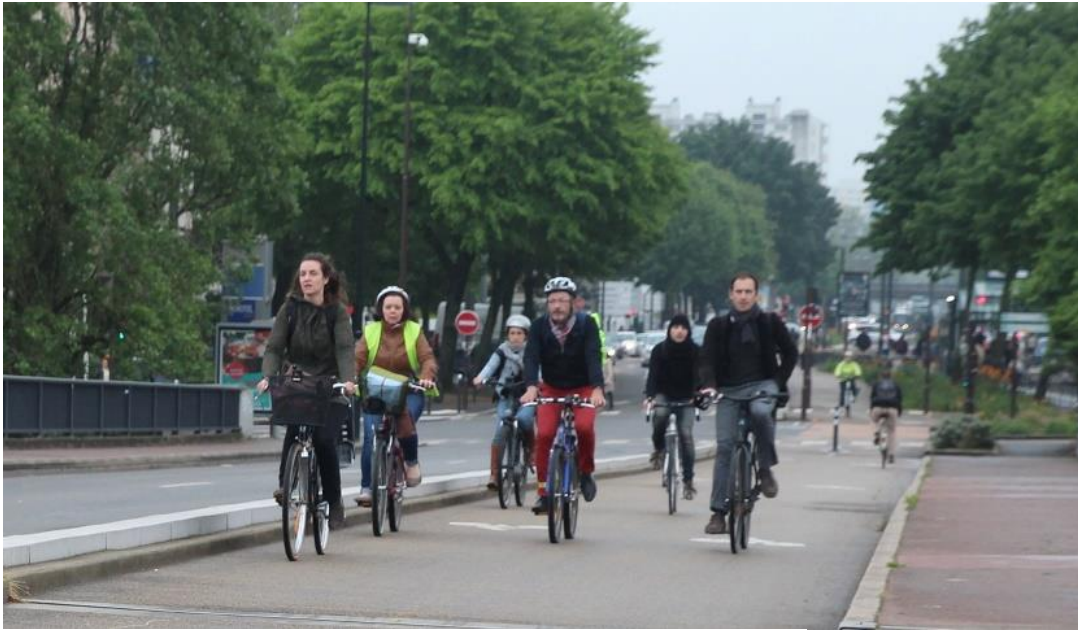
Nantes: piste cyclable bidirectionnelle bordant la chaussée générale
