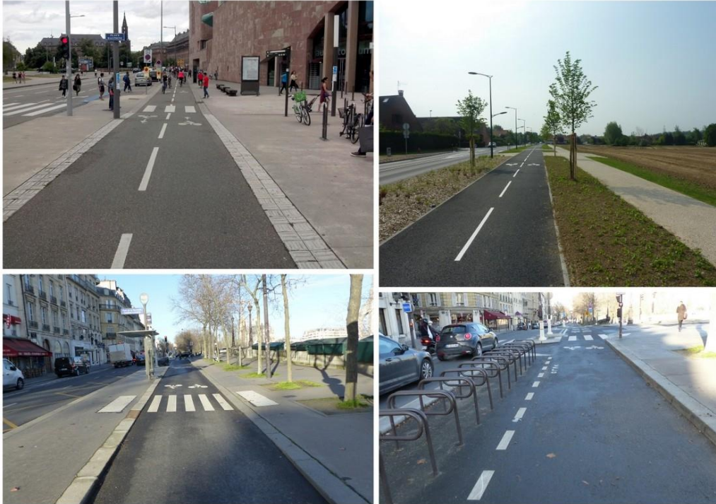
La bande technique peut accueillir : (1) Un espace de stockage pour la traversée piétonne (2) Un espace enherbé (3) Un arrêt TC (4) Du stationnement vélos
