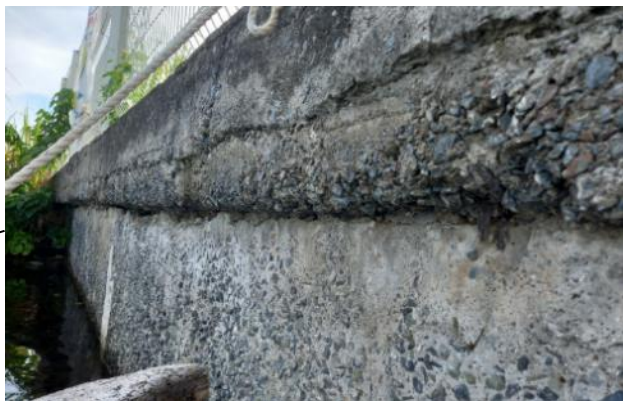
Zoom du mur de soutènement
