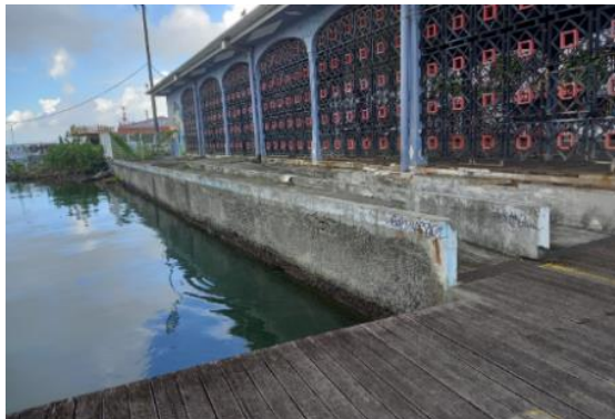
Mur de soutènement
