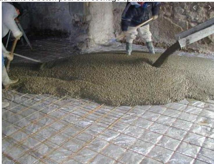
Figure 14 : exemple de polyane sous une dalle béton
