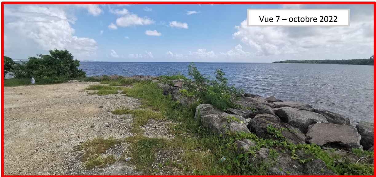
Figure 50 : Photographies du site
