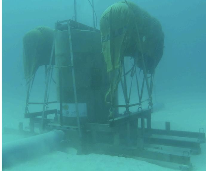
**Figure 6 :** Implantation du DPHI sur le fond marin sableux (photo sous-marine ATSM) au milieu de la zone sableuse. Compte tenu de la courte durée d'immersion les flotteurs gonflables ayant permis la mise en flottaison puis l'immersion du DPHI ont été maintenus en place pour faciliter la manœuvre de remise en flottaison pour la désinstallation.
