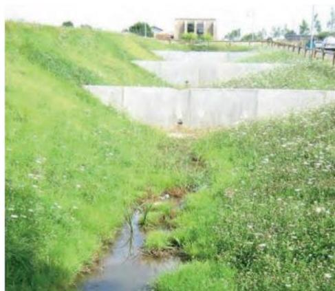
Figure 12 : Exemple de noue de rétention cloisonnée
