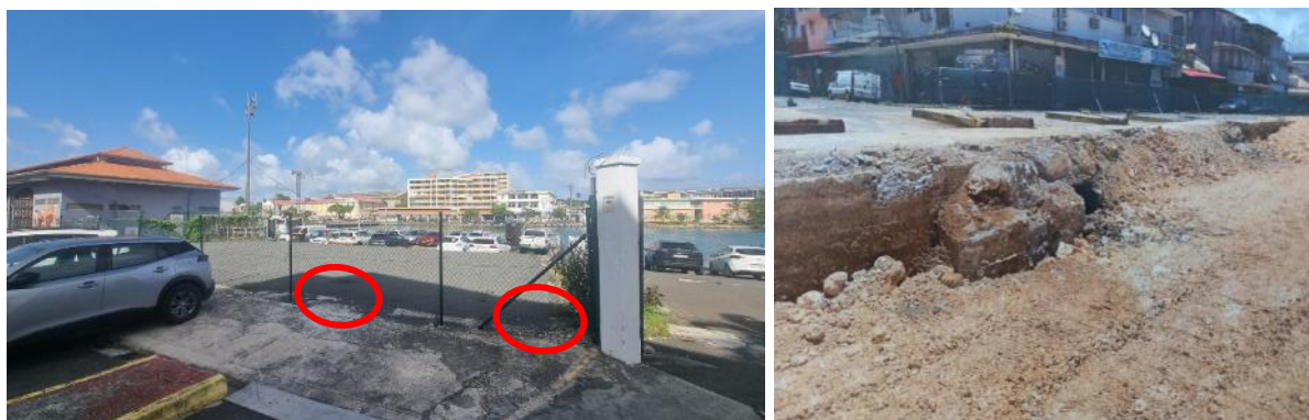
Figure 4 : Massifs de fondations restants sur plateforme haute
