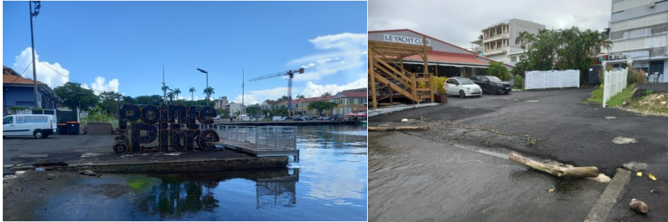
Figure 5 : Photo de la plateforme basse + ponton amovible (gauche) et parking du restaurant + cale de mise à l'eau (droite)
