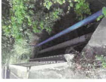
Ouvrage sur la rivière Mittan, détail sur réseaux
