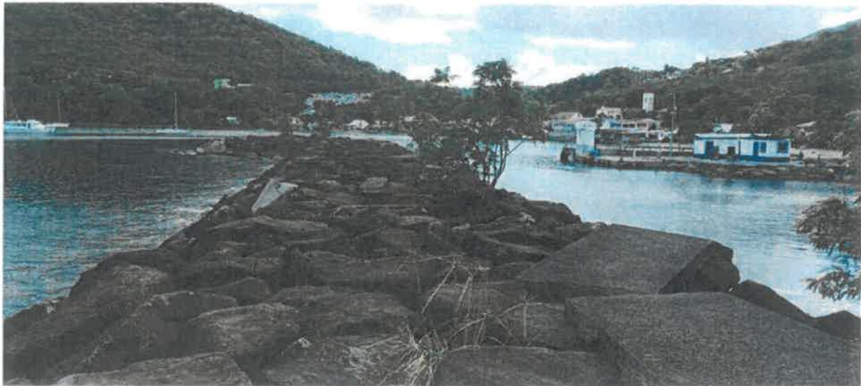
Figure 1-1 : Photographie de la digue Ouest du port de Deshaies
