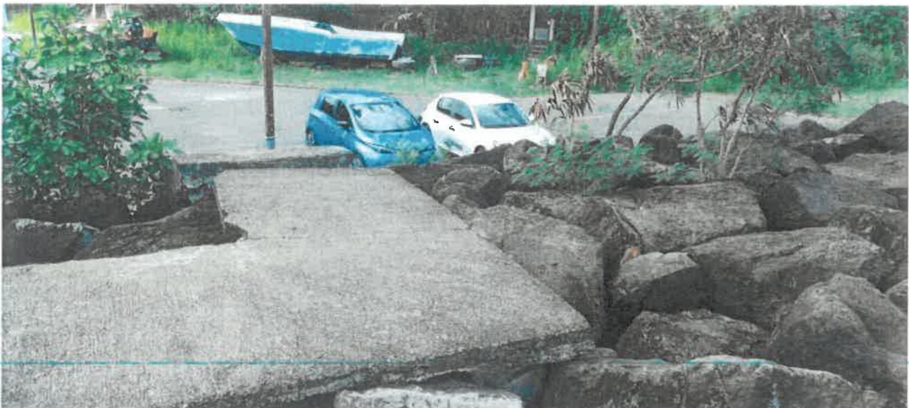
Figure 1-2 : Photographie d'une partie aménagée de la digue du port de Deshaies
