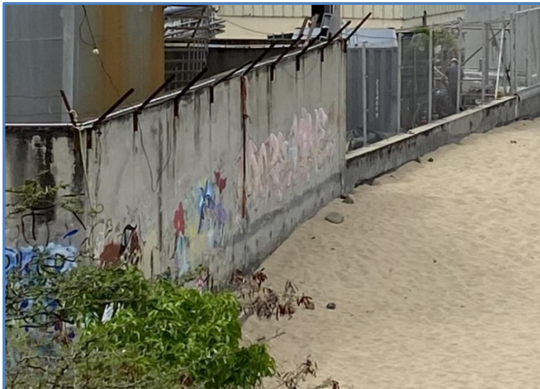
Photographie 3 – Vue du mur de la rétention de la bâche FOD 00 GDK 004 BA (à gauche) suivi du mur front de mer (à droite)
