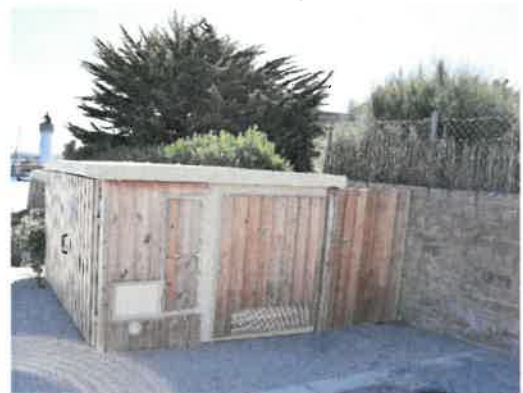
Figure 129: Exemple d'un local technique avec bardage en bois
