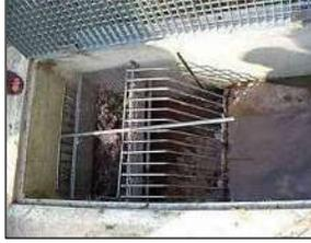
Figure 118 : Exemple de grille de protection
