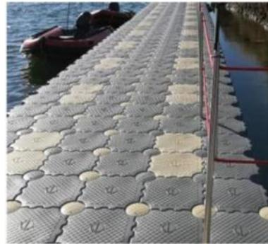
Figure 11 : Eléments pontons flottants modulaires
