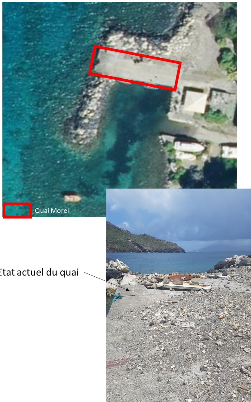
Figure 1 : Etat actuel du quai Morel
