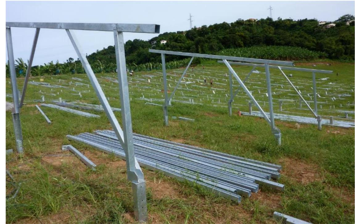
Photographie 3 : Ancrage sur pieu vis de la centrale Lassalle en Martinique (4MWc) (source : Albioma)
