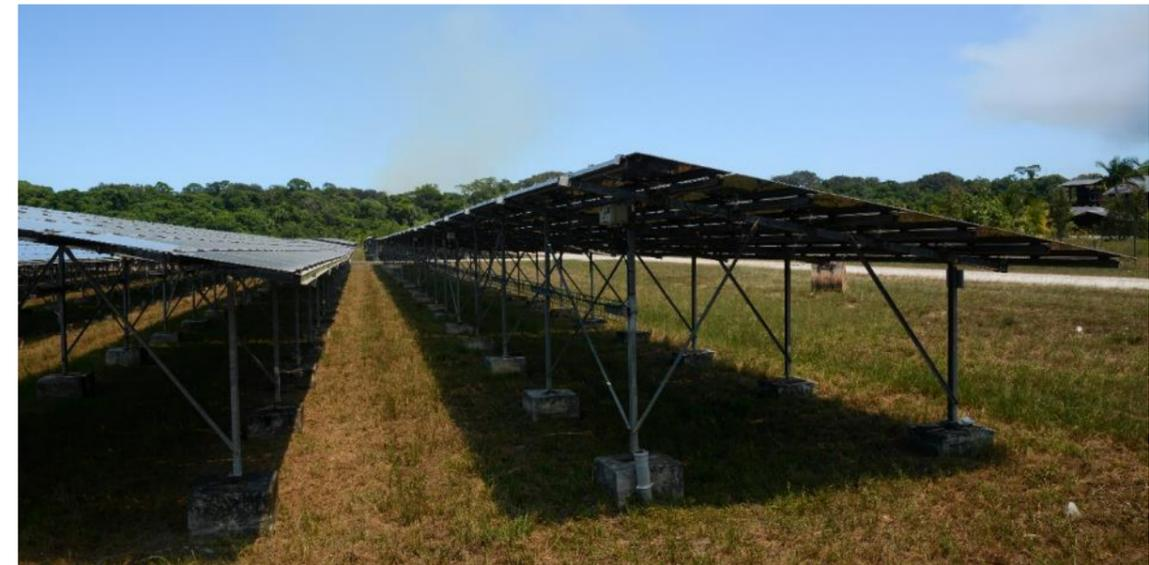
Photographie 2 : Fondation avec solution plots béton (source : Albioma)
