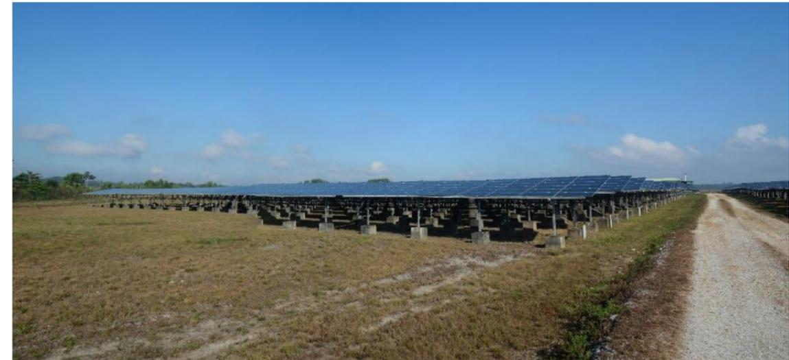
Photographie 1 : Exemple de fondation - Centrale photovoltaïque de Kourou [12 MW] (source : Albioma)
