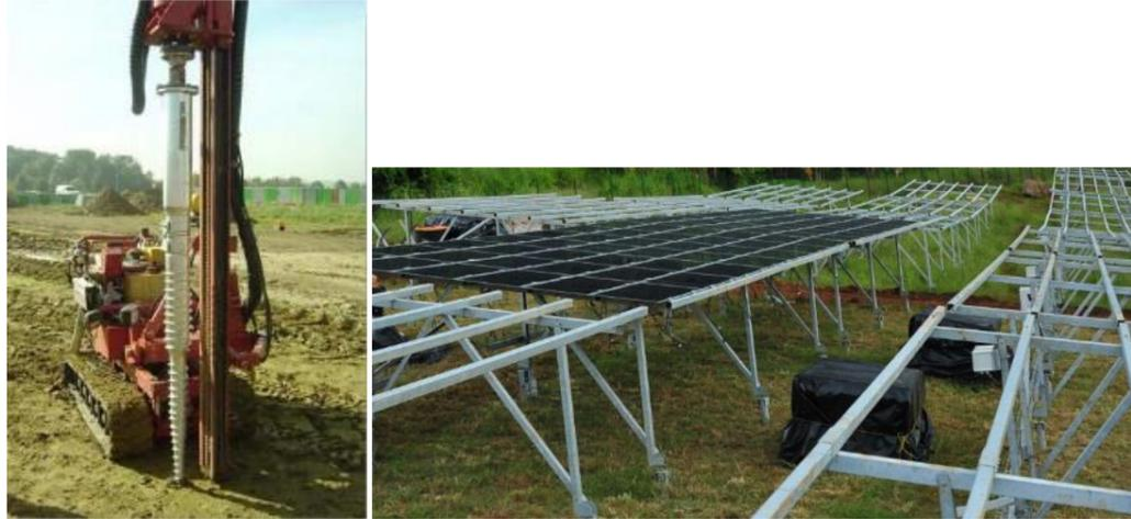
Figure 6 : Ancrage sur pieu vis (source : Albioma)
