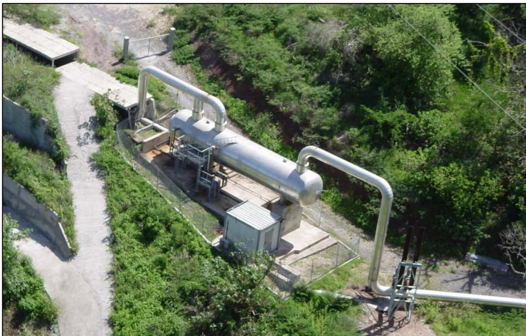
Figure 80 : Vue du ballon séparateur eau/vapeur HP existant qui sera remplacé par un ballon séparateur plus grand pour prendre en compte le surcroît de fluide qui sera apporté par le puits BO-12.
