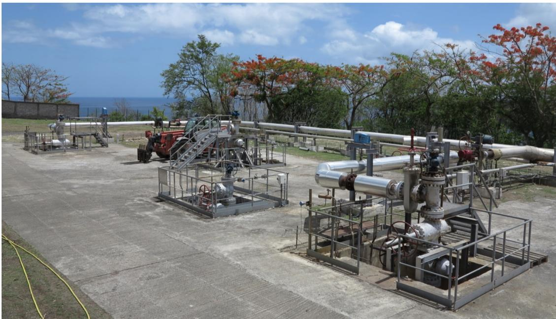
Figure 75 : Vue générale de la plateforme actuelle de Plateau illustrant une plateforme d'exploitation de puits géothermiques. A noter que cette plateforme comporte 4 têtes de puits (BO-4, BO-5, BO-6, BO-7) alors que les nouvelles plateformes des puits BO-11 et BO-12 ne comporteront qu'un seul puits.
