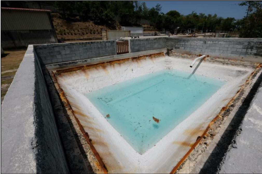
Figure 63 : Bassin de rétention bétonné sur la plateforme des puits actuelle destiné à recueillir le fluide géothermal déchargé durant les phases transitoires d’ouverture et de chauffe des puits, et de maintien en température.
