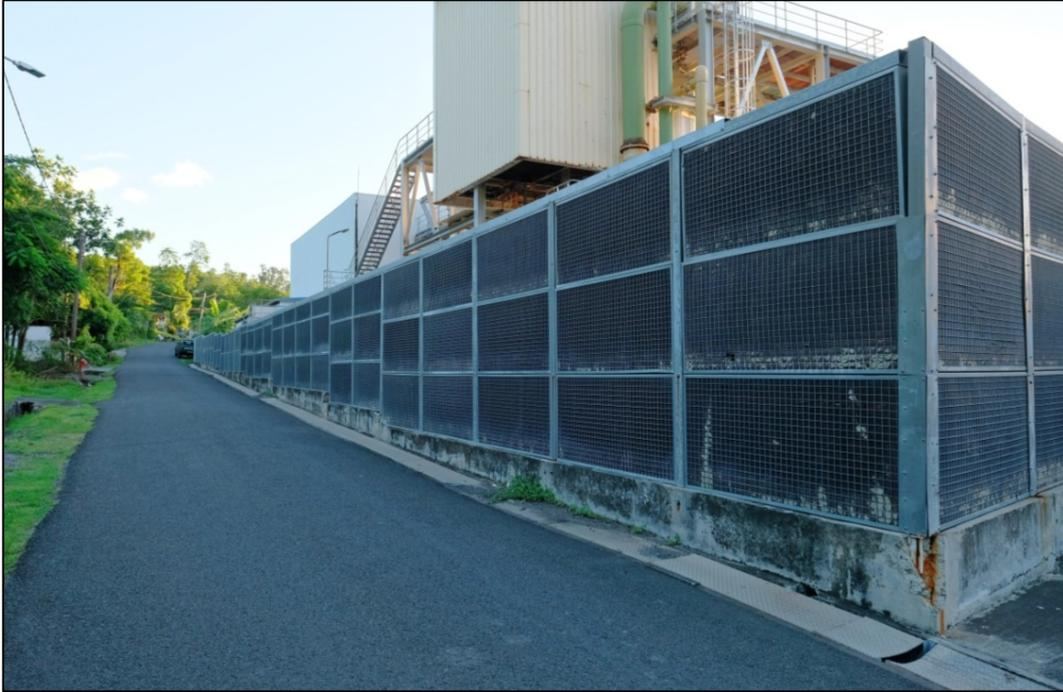
Figure 69 : Exemple de mur anti-bruit mis en place au niveau de la clôture du site de la centrale dans la rue Vanier et qui pourrait être installé en périphérie du chantier de forage pour réduire ses nuisances sonores.
