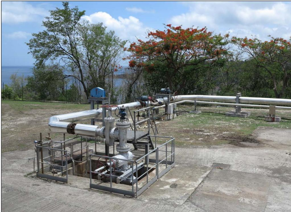
Figure 78 : Vue du puits BO-6 sur la plateforme de Plateau illustrant la tête d'un puits géothermique placée dans une cave bétonnée, munie de vannes d'isolement et connectée à une conduite de transport des fluides calorifugée. La cave est entourée d'une barrière de sécurité. La tête de puits est maintenue par des traverses métalliques prenant appui sur les murs de la cave pour limiter ses mouvements en cas de séisme.
