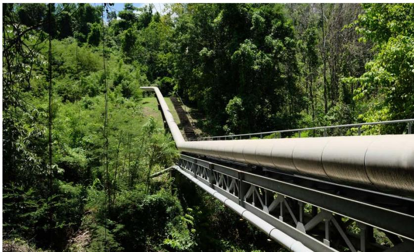
Figure 79 : Tronçon de la conduite diphasique qui transportera le fluide délivré actuellement par les puits BO-5 et BO-6 et par le futur puits BO-12 de la plateforme des puits jusqu'au ballon séparateur eau/vapeur HP.
