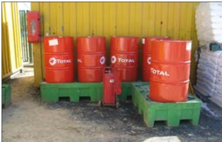
Figure 74 : Bacs de rétention et stockage d’huile sur un chantier.
