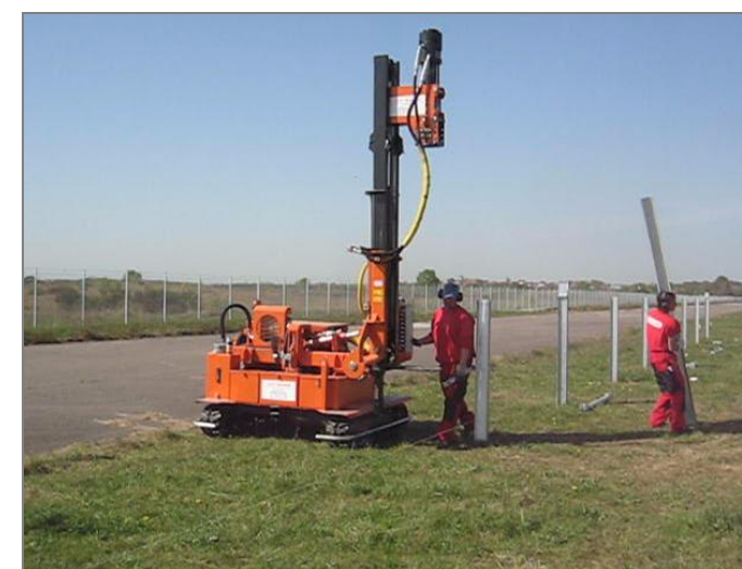
Illustration 11 : Battage des pieux et test verticalité
