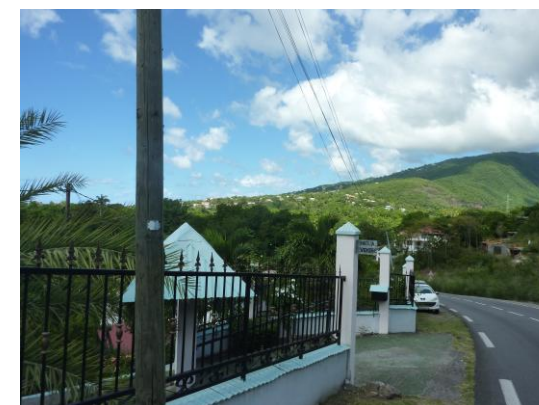
Illustration 43 : Vue de la RN2, à proximité des lotissements en construction sur le morne Marigot
