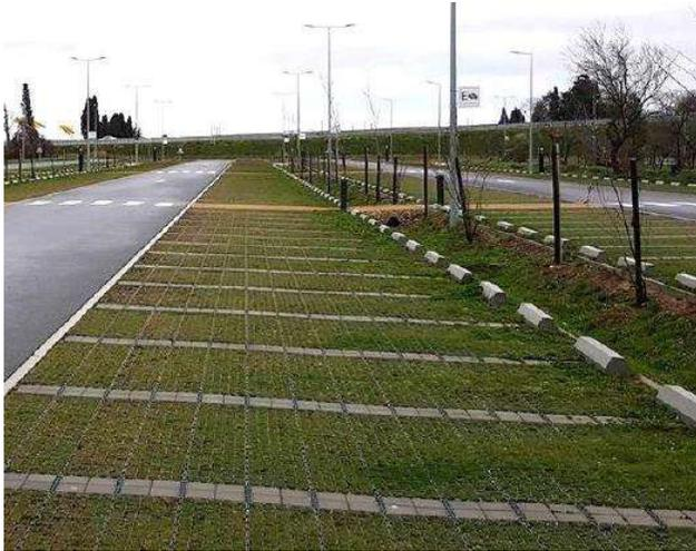
Figure 6 : Exemple de parkings perméables
