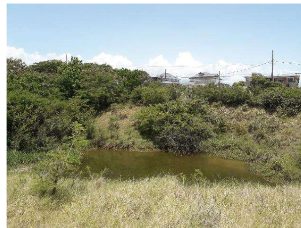
Figure 55 : Bassin de compensation existant (photographie du 23/05/2022 – Suez Consulting)
