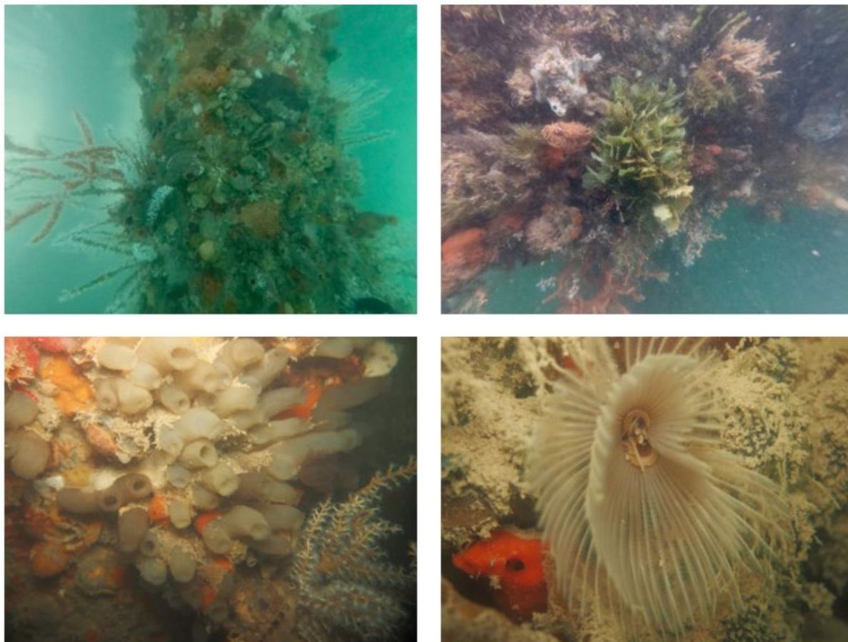
Figure 51: Exemples de colonisation des pieux du quai par un assemblage dense d'algues, d'éponges, de gorgones, de polychètes, de tuniciers, d'ascidies, d'hydrides, etc. (2020)
