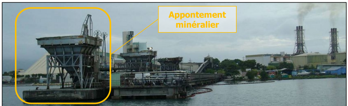
Figure 11 : Photographie du quai n°9 et de l'appontement minéralier correspondant à la zone de travaux
