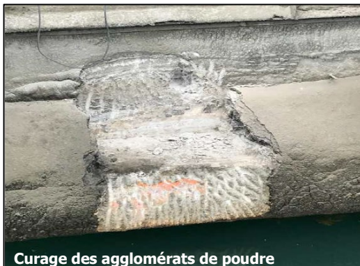
Figure 12: Exemples de travaux sur structure béton (Source : ALBIOMA LE MOULE 2019, GPMG 2011)
