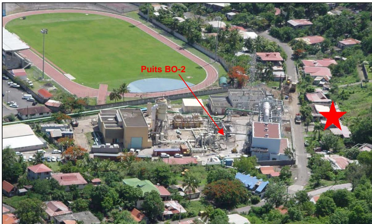
Figure 6 : Photographie aérienne de l'usine géothermique implantée dans le bourg de Bouillante avec l'unité Bouillante 1 (bâtiment de gauche), l'unité Bouillante 2 (bâtiment de droite) et la localisation du puits BO-2, et la Rue Vanier qui borde le site à l'est.
