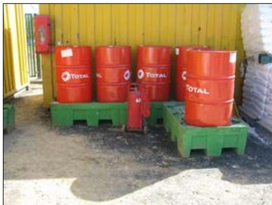
Figure 33 : Bacs de rétention et stockage d'huile sur un chantier
