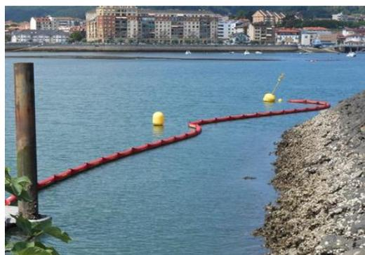
La fixation des barrages doit se faire impérativement au niveau des extrémités et a aucun moment par les poignées de manutention en crête de barrage
